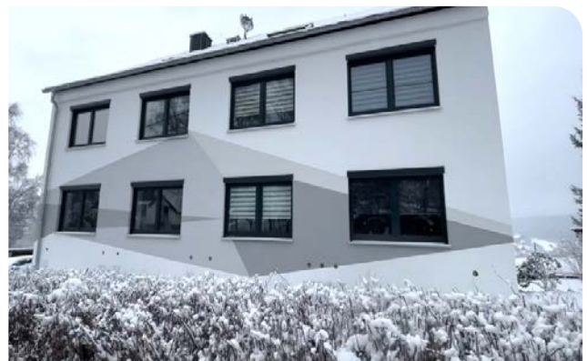
Energieeffiziente und klimafreundliche LowEx-Systeme für Mehrfamilienhäuser in den Bestand zu integrieren und zu optimieren: Das ist das Ziel im Projekt LowEx-Bestand.
