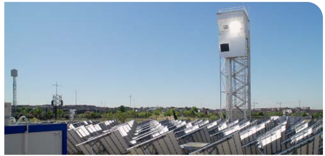
Die Solarturmanlage bei IMDEA Energía in der Nähe von Madrid: Hier haben Forschende erfolgreich demonstriert, wie synthetisches Kerosin aus Wasser und CO 2 gewonnen werden kann.
